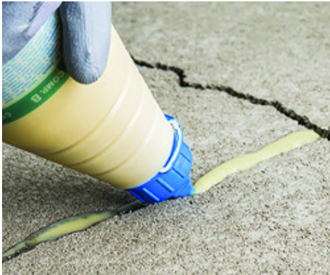
Einfüllen des Produktes in den Riss mithilfe der Tülle
