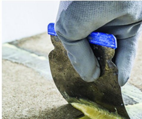
Gleichmäßiges Verteilen des Produktes zum Füllen des Risses
