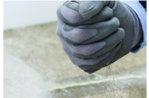
Abstreuen des Produktes mit Quarzsand 1,2 oder sauberem Quarzsand im frischen Zustand als Haftbrücke für nachfolgende Schichten
